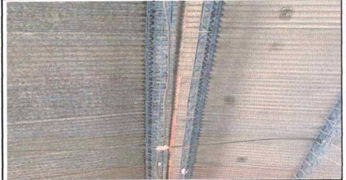
Foto 2: REPARACIÓN Y MANTENIMIENTO DE ESTRUCTURA DE TECHO
