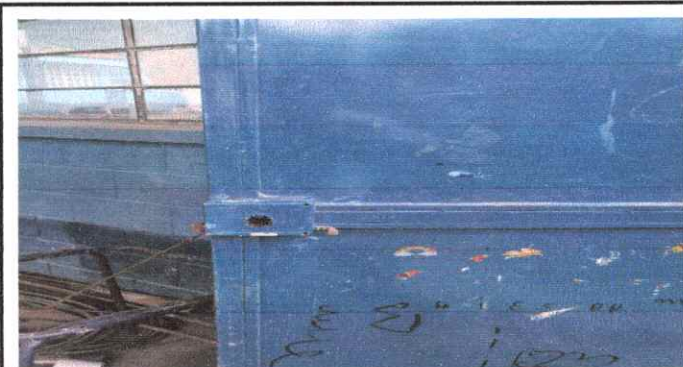
Foto 3: REPARACIÓN Y MANTENIMIENTO PUERTAS EN AREA DE AULAS
