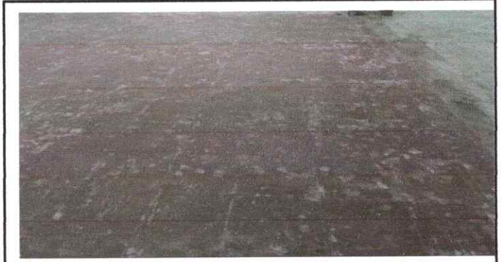
Foto 4: SUSTITUCIÓN PISO DE GRANITO (INCLUYE BASE CON MEZCLON)
