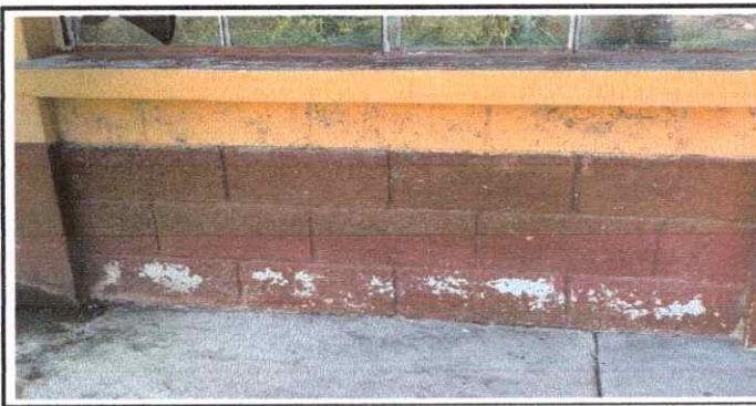
Foto 5: PINTURA EN MUROS INTERIOR Y EXTERIOR
