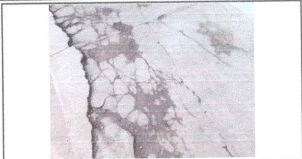
Foto1: SUSTITUCION PISO DE CEMENTO (DEMOLICION DE RESTOS, BASE, FUNDICION MAS ACABADO)
