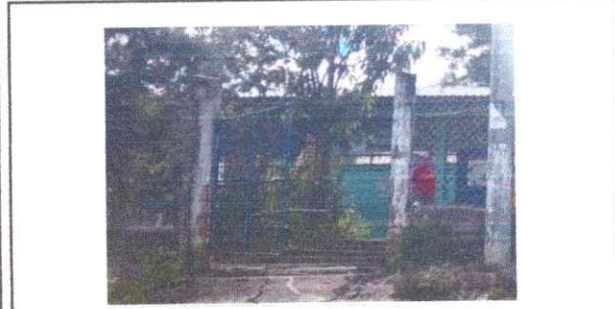
Foto 3: REPARACION Y MANTENIMIENTO A PORTON
