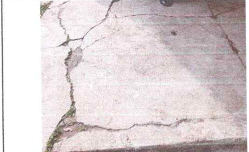
Foto 4: SUSTITUCIÓN LOSA DE PATIO INCLUYE, BASE, FUNDICION Y ACABADO
