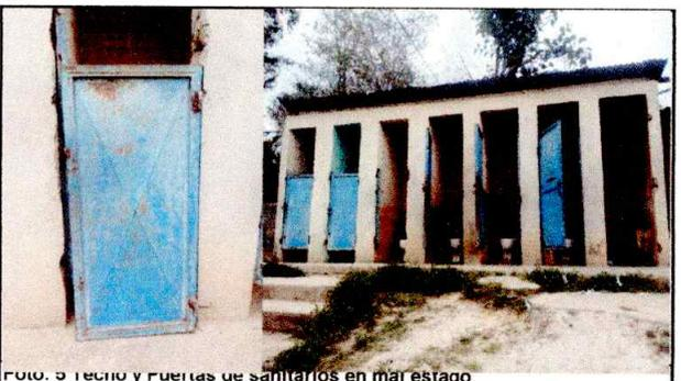
Foto. 5 techo y puertas de sanitarios en mal estado
