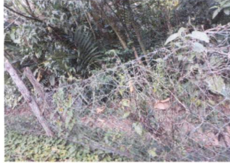
foto No 2. Muro perimetral en malas condiciones
