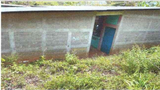
Pintura en Muros Exteriores e Inferiores 9.1
