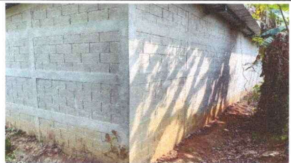
Pintura en Muros Exteriores e Inferiores 9.1
