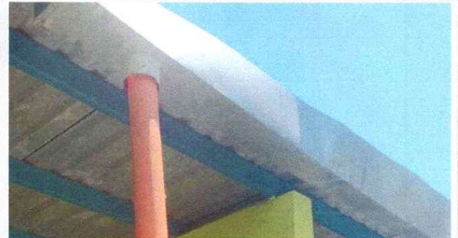
7. Canales y vajada de agua pluvial.
