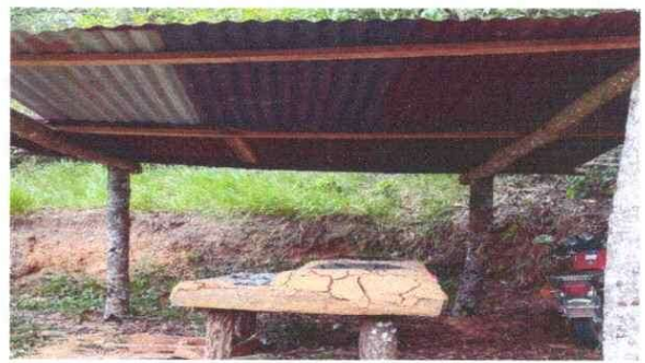
1. Cubierta de lámina 1.1
