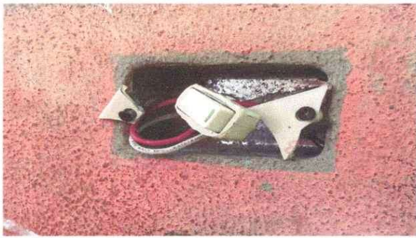
17. Reparación de sistema eléctrico
