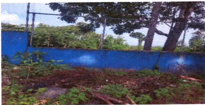
5. REPARACIÓN DE MURO, MALLA GALVANIZADA
