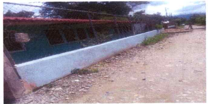
4. PINTURA DE MURO INTERIOR Y EXTERIOR
