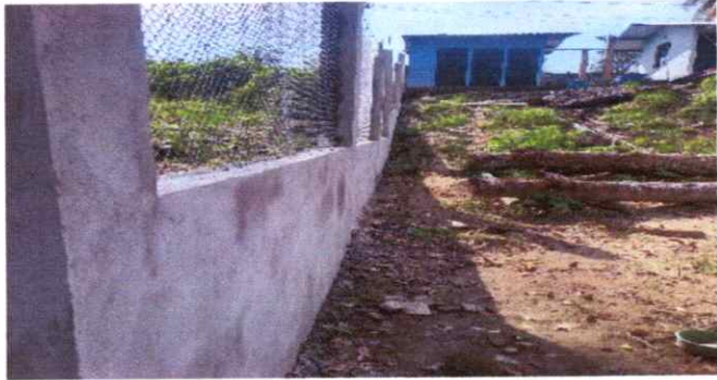
1. REPARACIÓN DE MURO DE BLOCK
