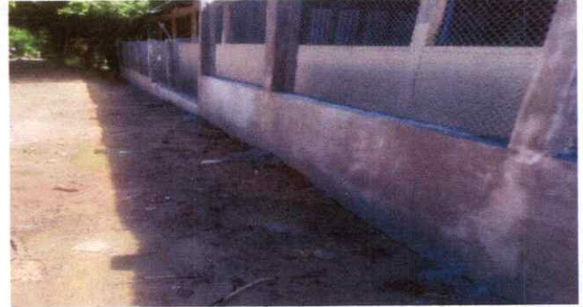
2. REPARACIÓN DE MURO DE BLOCK
