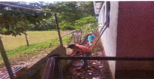
3. REPARACIÓN Y COLOCACIÓN DE MURO PERIMETRAL, MALLA GALVANIZADA3
