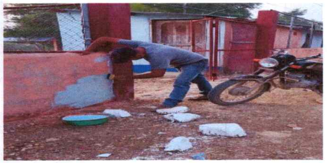
4. PINTURA INTERIOR Y EXTERIOR DEL ESTABLECIMIENTO
