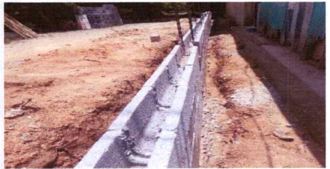
2. REPARACIÓN DE MURO MALLA GALVANIZADA
