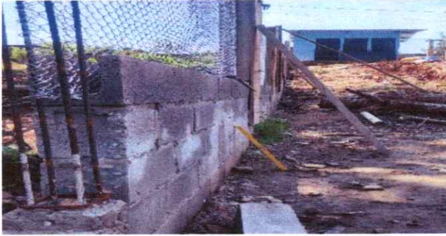
1. REPARACIÓN DE MURO DE BLOCK
