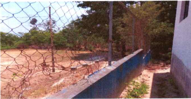
3. REPARACIÓN DE MURO PERIMETRAL BLOCK CON TUBO HG
