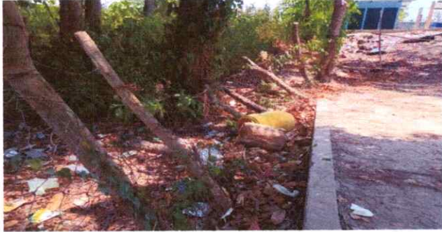
1. REPARACIÓN DE MURO DE BLOCK
