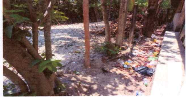
2. REPARACIÓN DE MURO DE BLOCK
