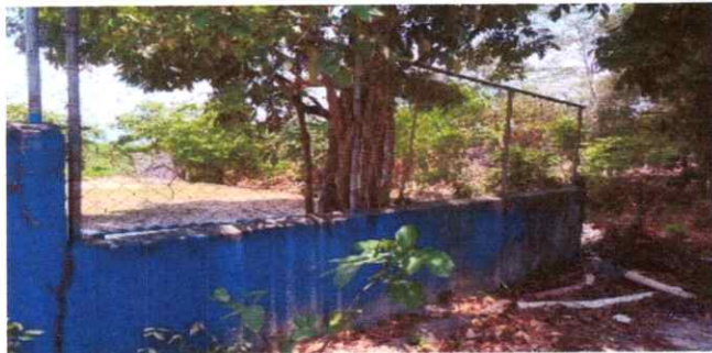
5. REPARACIÓN DE MURO MALLA GALVANIZADA
