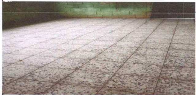
FOTO 2: REPARACION DE PISO GRANITO
