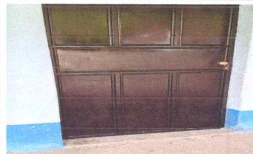
FOTO 6: INSTALAR CHAPA Y PINTAR
