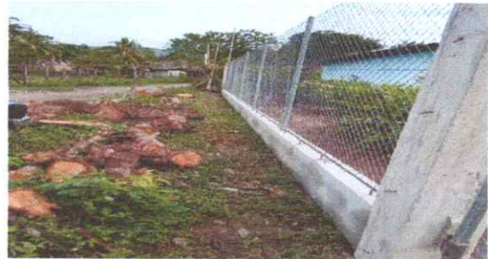
FOTO 4: INSTALACION DE MAYA
