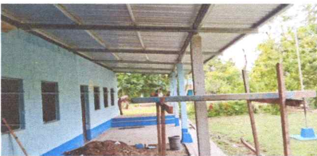
FOTO 5: CAMBIAR INSTRUCTURA DE MADERA X METAL
