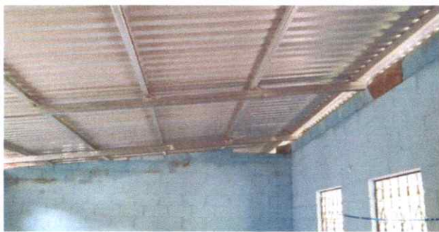
FOTO 3: CAMBIAR BIGA DE MADERA X METAL
