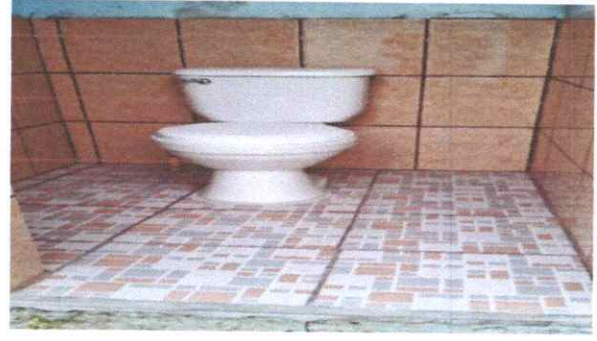
FOTO 2: INSTALACION DE CERAMICA
