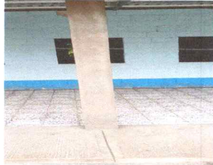
FOTO 2 CAMBIO DE MADERA POR METAL
