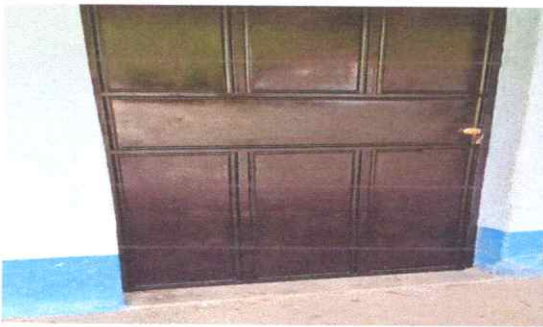
FOTO 3: MANTENIMIENTO DE PUERTAS DE METAL
