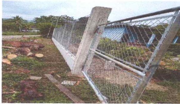
FOTO 3: INSTALACIÓN DE MAYA
