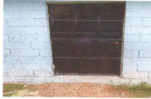
FOTO 4: CAMBIAR PUERTA DE MADERA X METAL
