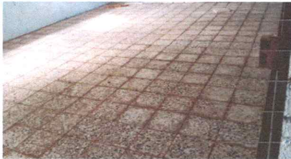
FOTO 1: REPARACION DE PISO X GRANITO
