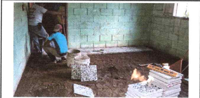
FOTO 1: REPARACION DE PISO X GRANITO
