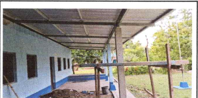
FOTO 5: CAMBIO DE ESTRUCTURA DE MADERA X METAL
