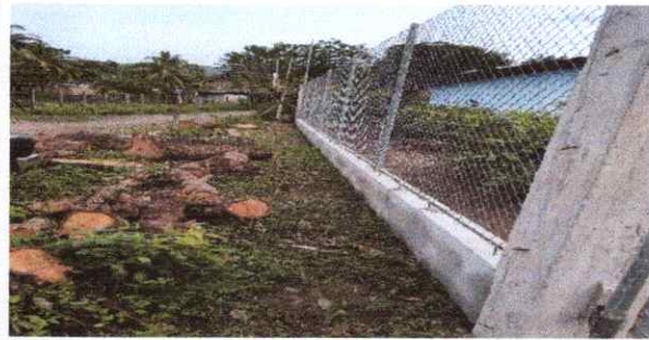
FOTO 4: INSTALACION DE MAYA
