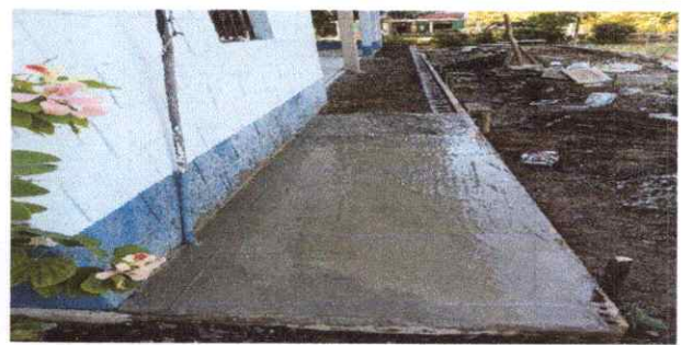
FOTO 2: REPARACION DE CERA
