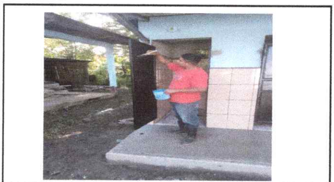
FOTO 3: MANTENIMIENTO DE PUERTAS DE METAL
