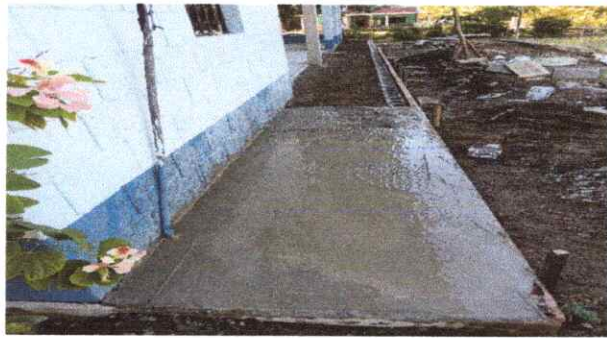
FOTO 1: REPARACION DE CERA
