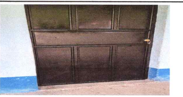
FOTO 6: INSTALAR CHAPA Y PINTAR
