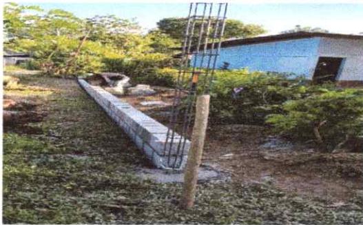
FOTO 3: INSTALACIÓN DE MAYA
