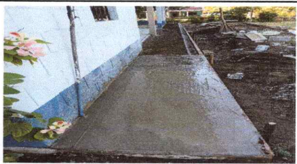
FOTO 4: REPARACION DE CERA
