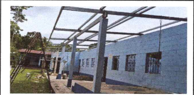
FOTO 3: CAMBIAR BIGA DE MADERA X METAL
