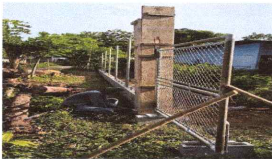
FOTO 5: RECONSTRUIR BASE PARA PUERTA
