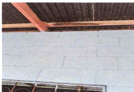
FOTO 3: CAMBIAR BIGA DE MADERA X METAL
