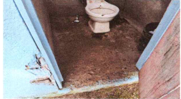
FOTO 2: INSTALACION DE CERAMICA
