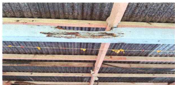
FOTO 5: CAMBIAR INSTRUCTURA DE MADERA X METAL
