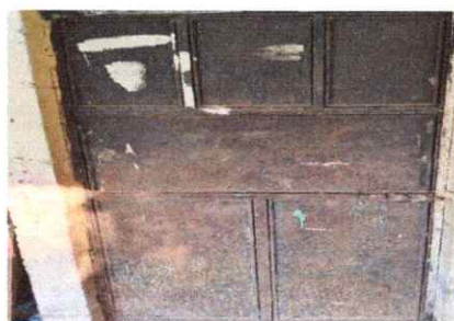
FOTO 6: INSTALAR CHAPA Y PINTAR
