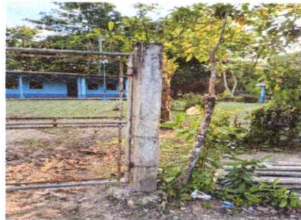
FOTO 6: SUSTITUCION DE MURA DE PORTON
