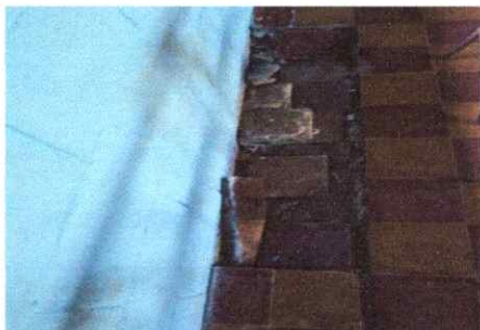
FOTO 1: REPARACION DE PISO X GRANITO
