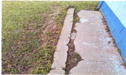
FOTO 1: REPARACION DE CERA
