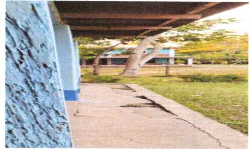
FOTO 2: REPARACION DE CERA
