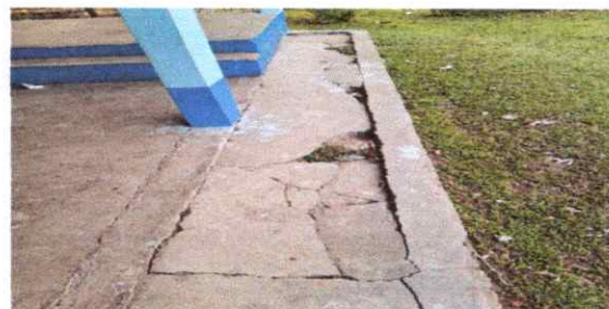
FOTO 4: REPARACION DE CERA
