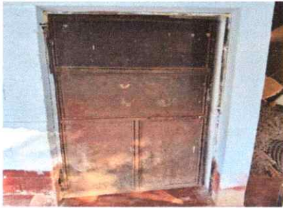
FOTO 3: MANTENIMIENTO DE PUERTAS DE METAL
