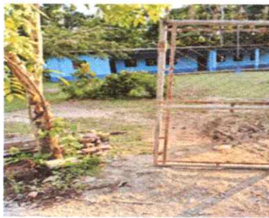
FOTO 5: RECONSTRUIR BASE PARA PUERTA
