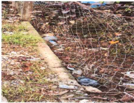
FOTO 3: INSTALACIÓN DE MAYA
