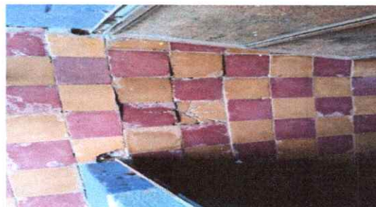
FOTO 2: REPARACION DE PISO GRANITO
