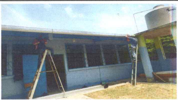
Mejoramiento de canales y caída de agua.
