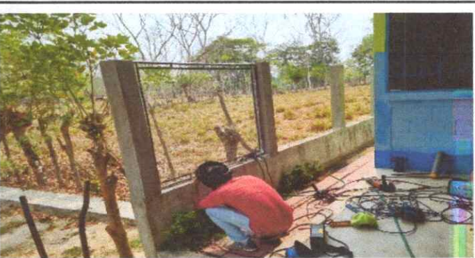
Reparación de muro con malla galvanizada.
