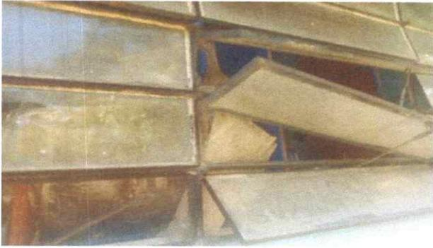
**CAMBIO DE ESTRUCTURA METALICA Y VENTANAS DE VIDRIO ROTAS POR ESTRUCTURA METALICA Y VIDRIO**
