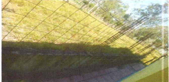
**REPARACION DE MURO CON MALLA GALVANIZADA**
