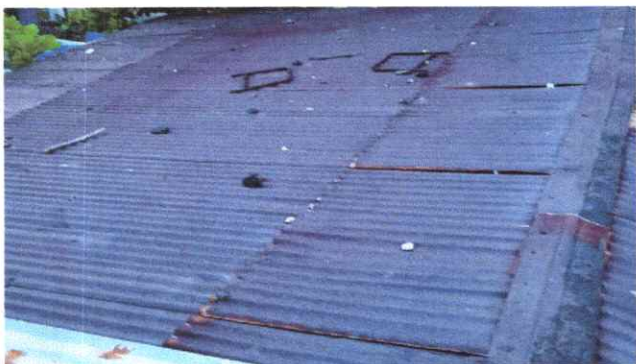
1) LA LÁMINA ESTA OXIDADA Y ROTA POR TENER MAS DE 20 AÑOS DE SERVICIO
