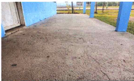
5) EL PISO ESTA CON GRIETAS DETERIORADOS Y ES NECESARIO SUSTITUIRLO
