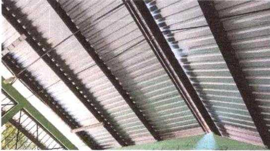
Cubierta, Sustitución de lamina, por lámina troquelada aluzinc
