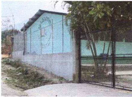
Reparación de muro perimetral de block con tubo hg y malla galvanizada, soleras intermedias y columnas
