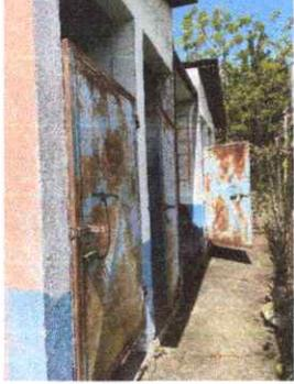
Mantenimiento a estructura (lijado, cambio de tubo, cepillado, sujeciones, aplicación de pintura ) a puertas servicios sanitarios
