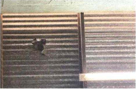
abierta, Sustitución de lamina, por lámina troquelada aluzinc
