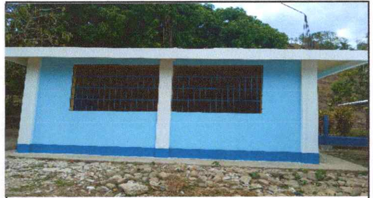
FABRICACION E INSTALACION DE BALCONES
