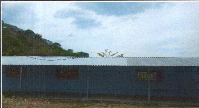
CUBIERTA DE LAMINA, TECHO Y TORTA DE CEMENTO
