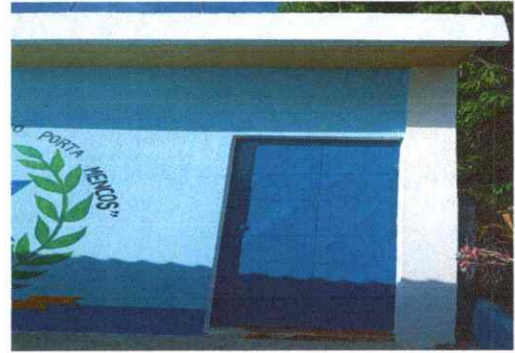
IMPERMEABILIZACION DE LOSA Y MANTENIMIENTO DE ESTRUCTURA DE PUERTA
