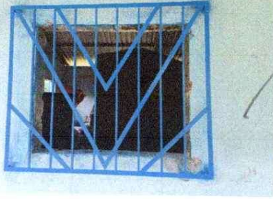
Foto 7: Mantenimiento a balcones de metal.
