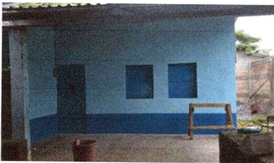
Foto 5: Mantenimiento a estructura de metal de ventana
