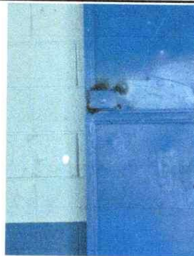
Foto 4: Sustitución de chapa
