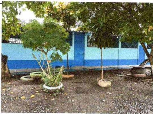
Foto 3: Mantenimiento a estructura de puerta (lijado y pintado)
