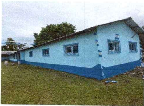
Foto 9: Pintura en muro exterior
