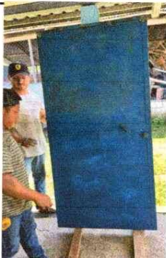
Foto 3: Mantenimiento a estructura de puerta (lijado y pintado)
