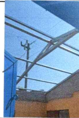
Foto 2: Sustitución de estructura de soporte de madera por metal.
