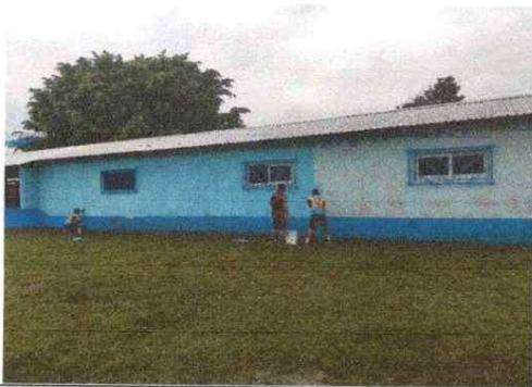
Foto 9: Pintura en muro exterior
