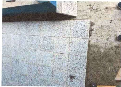
Foto 8: Sustitución de piso de torta de cemento por piso de granito.
