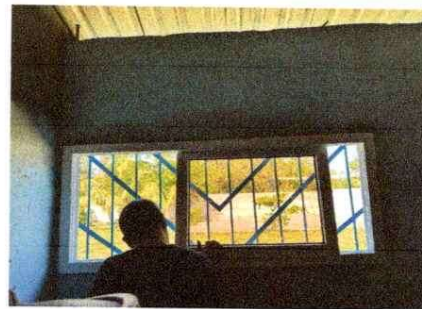
Foto 6: Sustitución de ventanas de madera por ventanas de PVC
