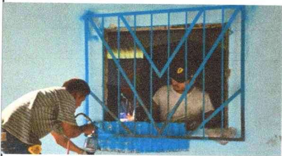
Foto 7: Mantenimiento a balcones de metal.
