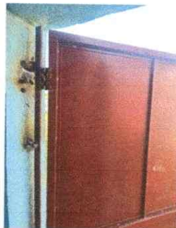
Foto 10: Mantenimiento a estructura de puerta de servicio Sanitario.
