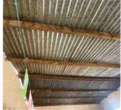
Foto 2: Sustitución de estructura de soporte de madera por metal.
