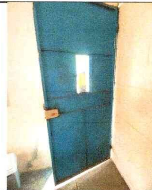
Foto 4: Sustitución de chapa
