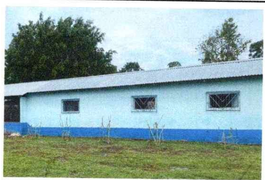
Foto 9: Pintura en muro exterior
