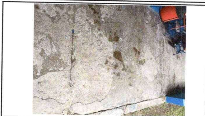
Foto 8: Sustitución de piso de torta de cemento por piso de granito.
