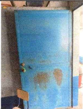
Foto 3: Mantenimiento a estructura de puerta (lijado y pintado)
