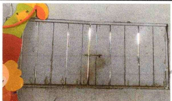
Foto 6: Sustitución de ventanas de madera por ventanas de PVC
