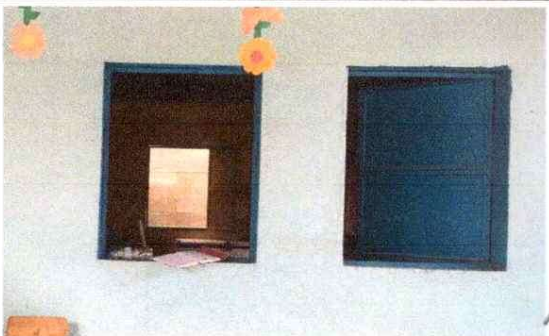
Foto 5: Mantenimiento a estructura de metal de ventana
