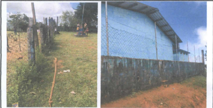
Reparación de muro perimetral de block con tubo hg y malla galvanizada, soleras intermedias y columnas.
