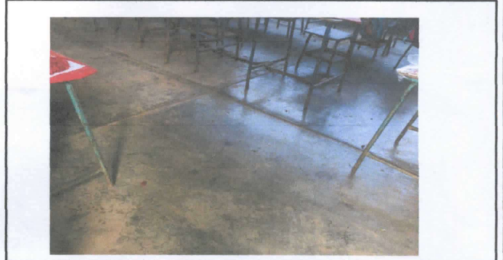
Sustitución de piso de granito
