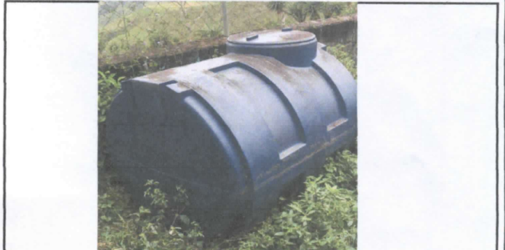
Instalación de depósito para agua
