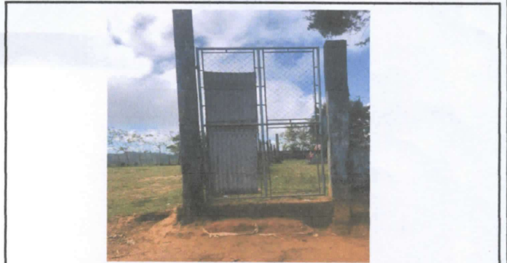
Sustitución de porton de la entrada principal
