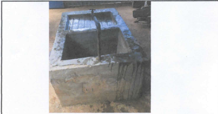
Reparación e instalación de azulejo en pila
