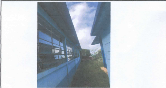
Sustitución de canal de pvc
