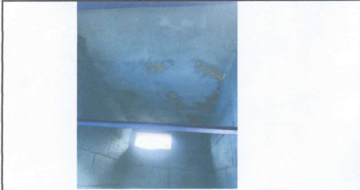
Impermeabilización de losa
