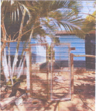
SUSTITUCIÓN DE PORTÓN DE METAL
