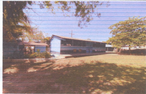
PINTURA EN MUROS EXTERIORES E INTERIORES
