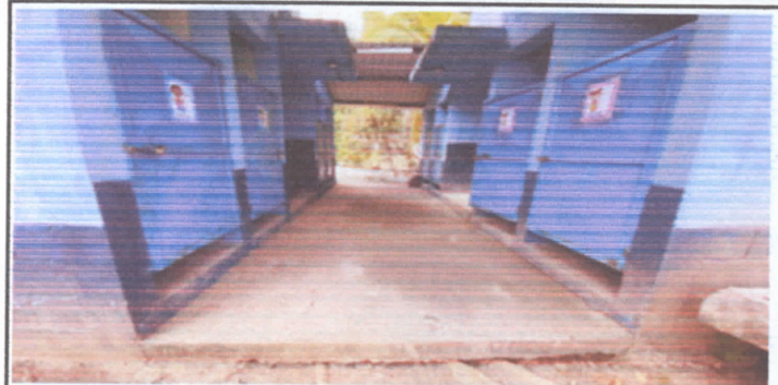
SUSTITUCIÓN DE PISO
