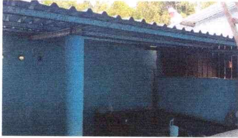
Foto 1: cubierta de lámina
