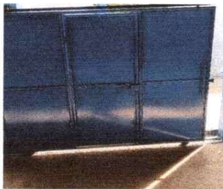
Foto 3.3 Sustitución de portón
