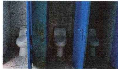
Foto 5.2: Sustitución de inodoros
