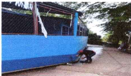
Foto 9: Reparación de repello
