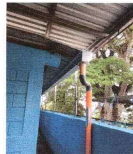
Foto 4 Canales y bajadas de agua pluvial
