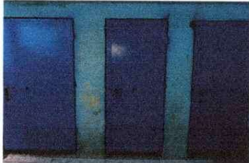
Foto 5: Servicios sanitarios y sus accesorios
