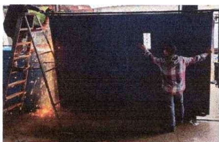
Foto 3.3: Sustitución de portón
