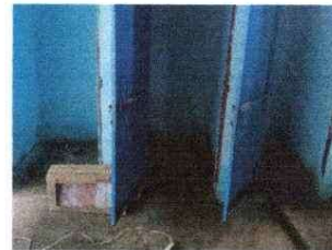
Foto 5.2: Sustitución de inodoros
