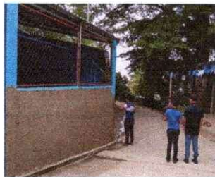
Foto 9: Reparación de repello
