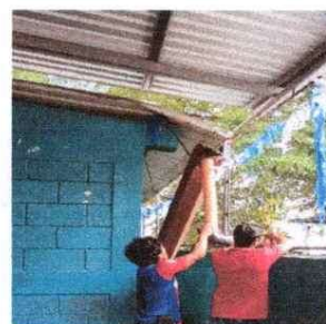
Foto 4: Canales y bajadas de agua pluvial
