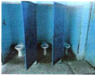
Foto 7: Reparación o sustitución de azulejos
