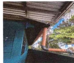
Foto 4 Canales y bajadas de agua pluvial
