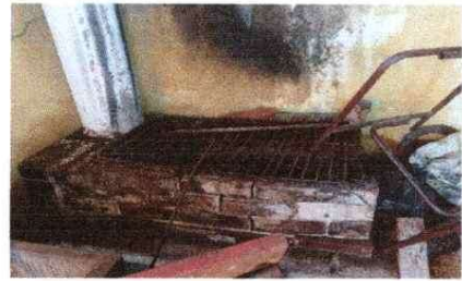
Foto 8: Reparación de cocina
