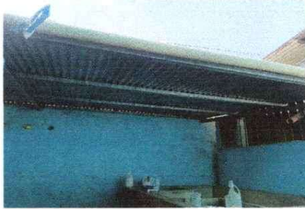
Foto 1: cubierta de lámina
