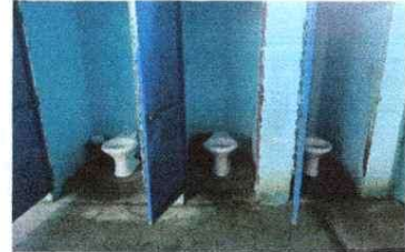
Foto 5.2 Sustitución de inodoros
