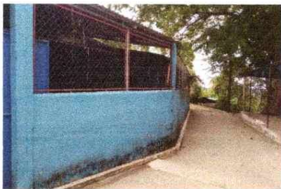
Foto 9: Reparación de repello
