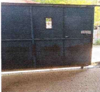
Foto 3.3 Sustitución de portón
