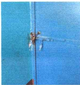
Foto 3.1: Sustitución de chapas
