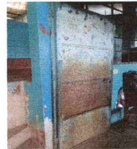
Foto 3.2: Sustitución de puerta
