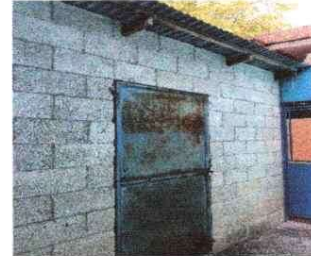
Foto 2: Estructura de techo
