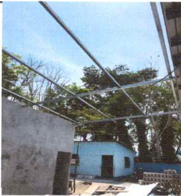
FOTO 3: Sustitución de estructura de soporte de madera por metal
