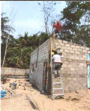
FOTO 5: Reparación de muro perimetral de contención
