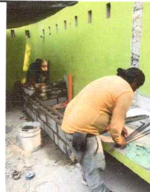
FOTO 4: Sustitución de pila de cemento de dos lavaderos
