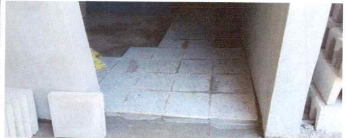
FOTO 2: Sustitución de piso de granito
