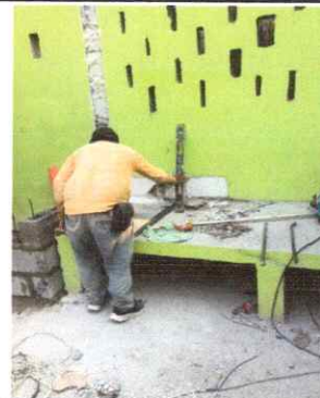
FOTO 6: Mantenimiento de estufa rural
