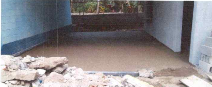
FOTO 1: Sustitución de piso de torta de cemento
