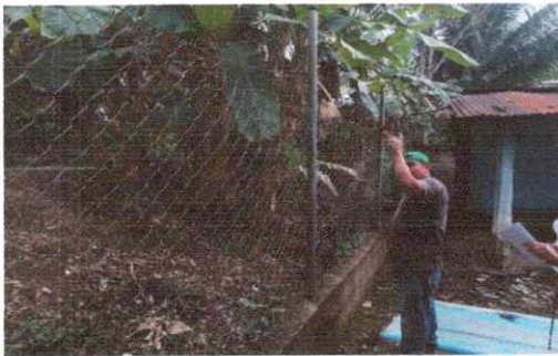
FOTO 5 Reparación de muro perimetral de block
