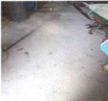
FOTO 3: Sustitucion de piso de granito
