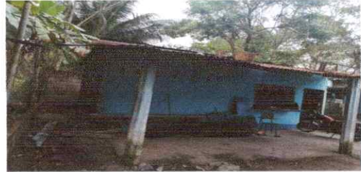
FOTO 2: Sustitución de lámina por lamina troquelada calibre 26
