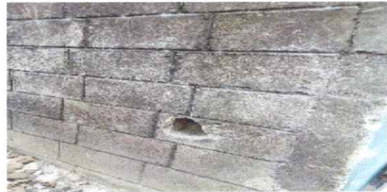
FOTO 4: Reparación de muro de contención
