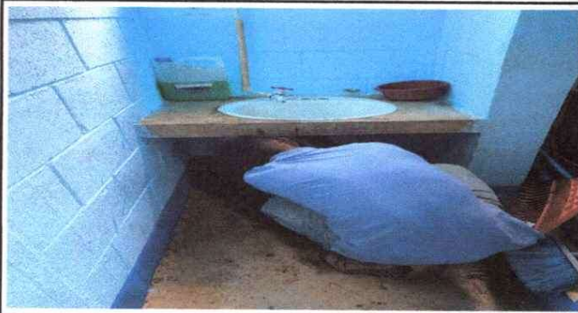
7. Sustitución de lavamanos
