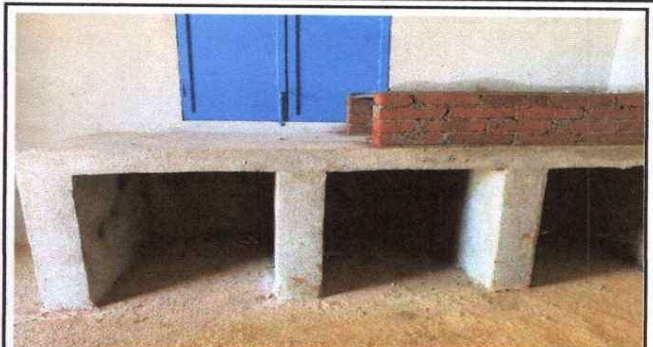
8. Instalación de azulejo en estufa rural
