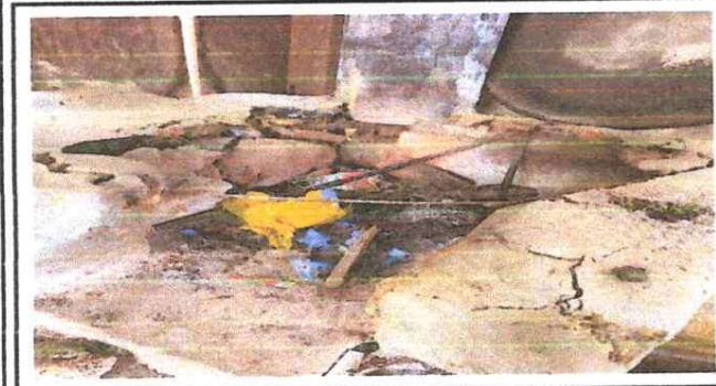
9. Sustitución de estufa rural (completa) incluye chimenea y plancha de metal
