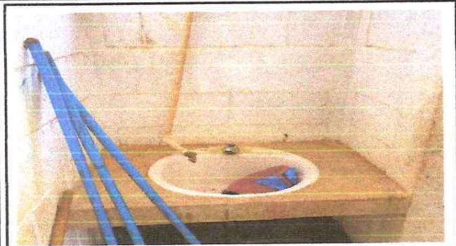
7. Sustitución de lavamanos
