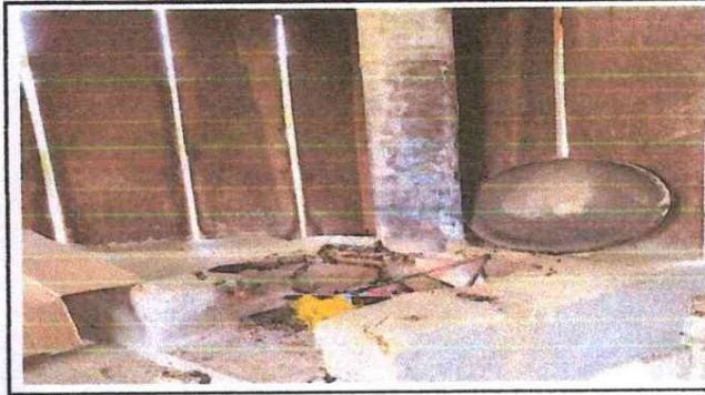
10. Sustitución de chimenea de cemento
