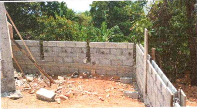
Reparacion de muro perimetral de block
