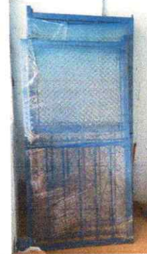
Fabricación e instalación de porton de metal de ingreso
