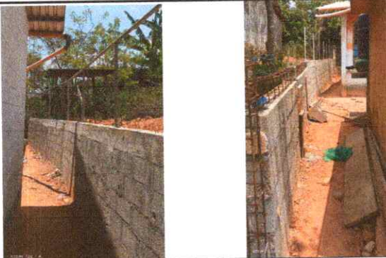
Reparación de muro de contencion
