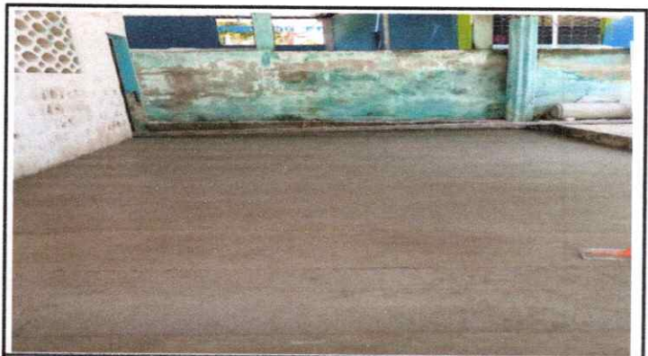
REPARACIÓN DE PLANCHAS DE CONCRETO DE PATIO
