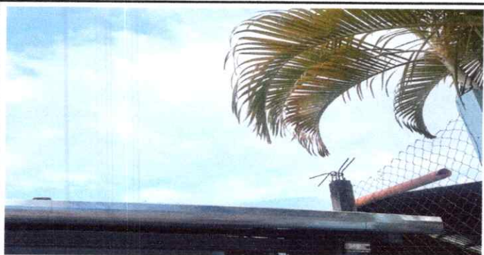
SUSTITUCIÓN DE CANAL DE METAL
