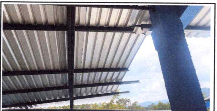
SUSTITUCIÓN DE LÁMINA
