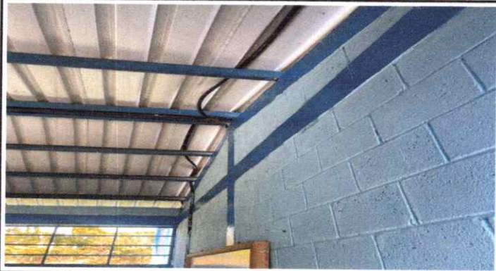
REPARACIÓN SISTEMA ELÉCTRICO
