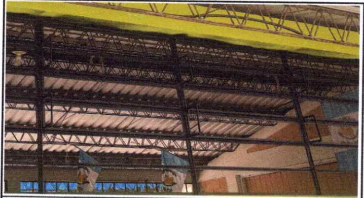
MANTENIMIENTO A BALCONES DE METAL
