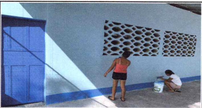
PINTURA EN MUROS EXTERIORES E INTERIORES
