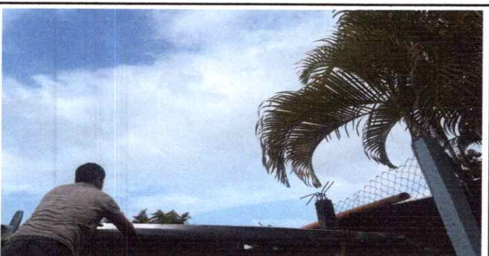
SUSTITUCIÓN DE CANAL DE METAL
