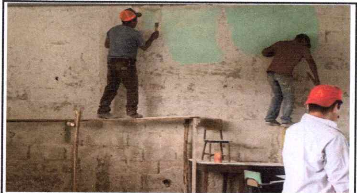
REPARACIÓN DE REPELLO
