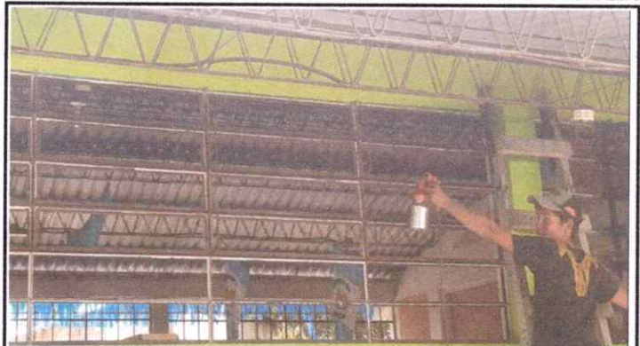
MANTENIMIENTO A BALCONES DE METAL
