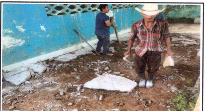
REPARACIÓN DE PLANCHAS DE CONCRETO DE PATIO
