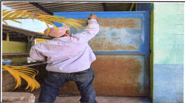
SUSTITUCIÓN DE CHAPAS Y MANTENIMIENTO DE LAS PUERTAS
