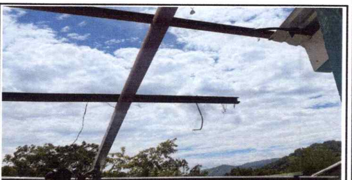
SUSTITUCIÓN DE LÁMINA
