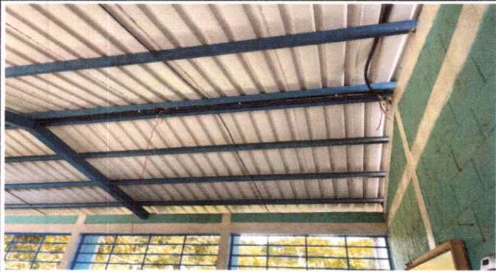
REPARACIÓN SISTEMA ELÉCTRICO
