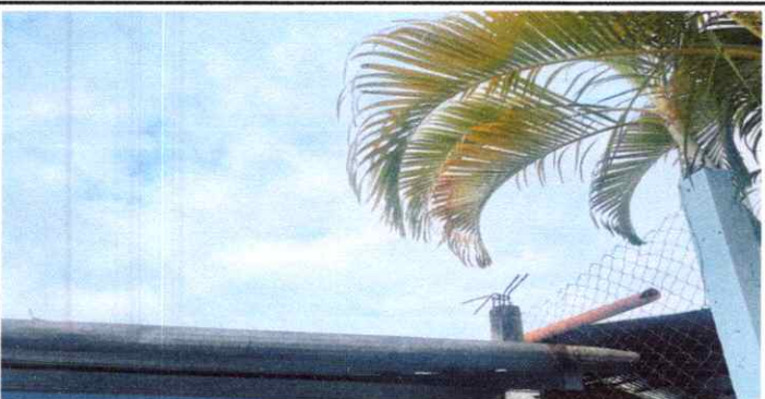
SUSTITUCIÓN DE CANAL DE METAL
