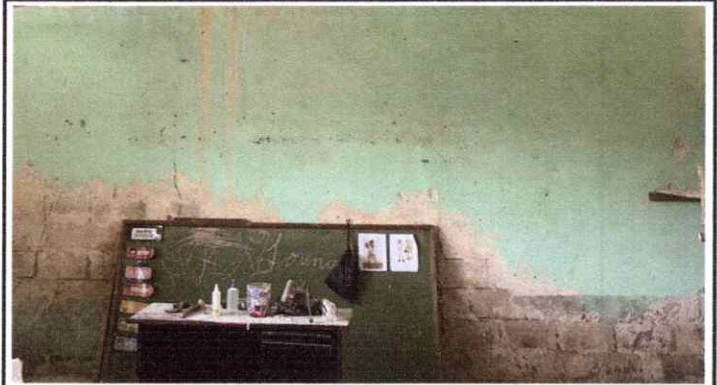
REPARACIÓN DE REPELLO
