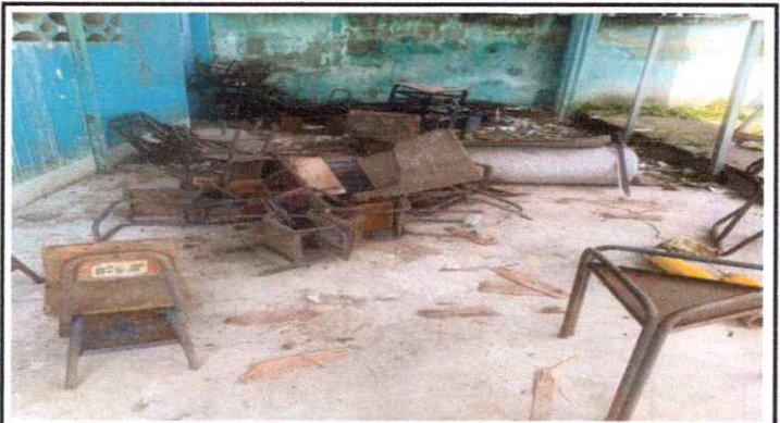
REPARACIÓN DE PLANCHAS DE CONCRETO DE PATIO
