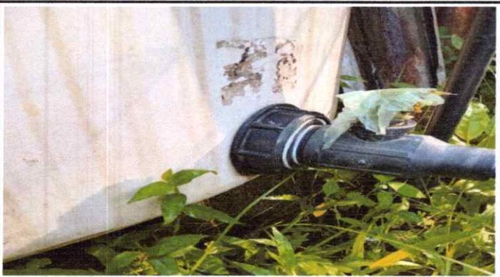
SUSTITUCIÓN DE DEPÓSITO DE AGUA 1100 LT
