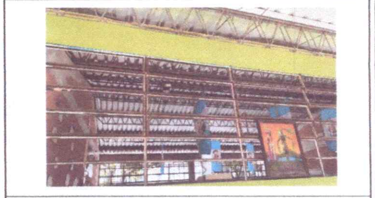
MANTENIMIENTO A BALCONES DE METAL
