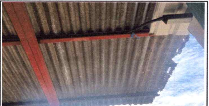
SUSTITUCIÓN DE LÁMINA
