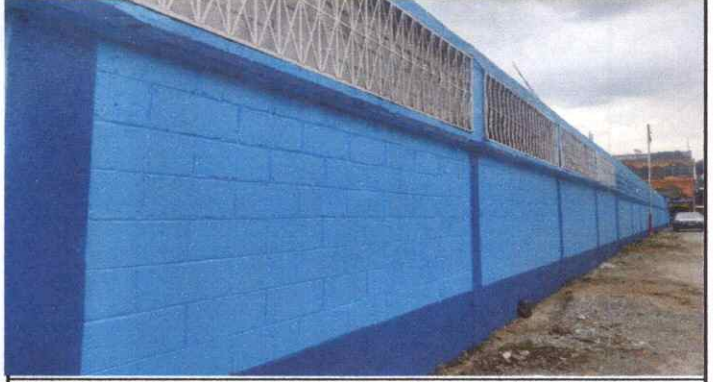
Foto 8: Aplicación de Pintura de Aceite en Exterior de Muro Perimetral.
