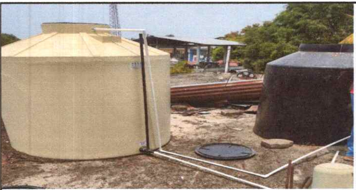
Foto 11: Instalación de Deposito de agua más grande, para abastecimiento de varias áreas del establecimiento.
