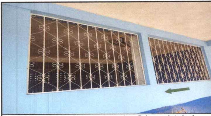
Foto 5: Mantenimiento y Pintura anticorrosiva a Balcones de todo el establecimiento.
