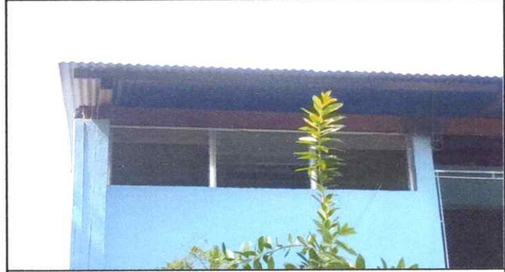
Foto 4: Sustitución de Persianas.
