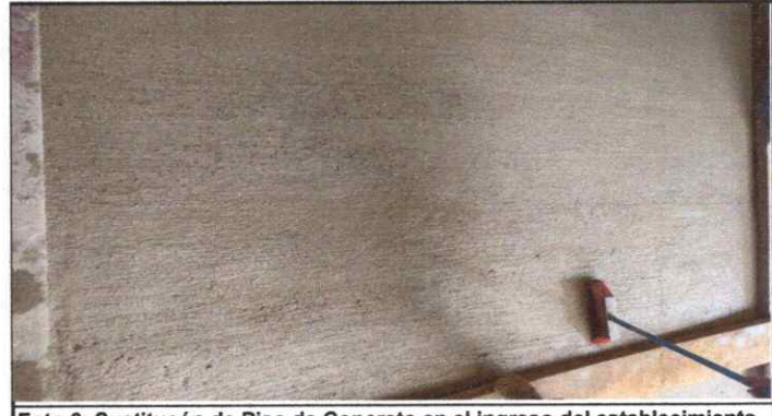
Foto 6: Sustitución de Piso de Concreto en el ingreso del establecimiento.
