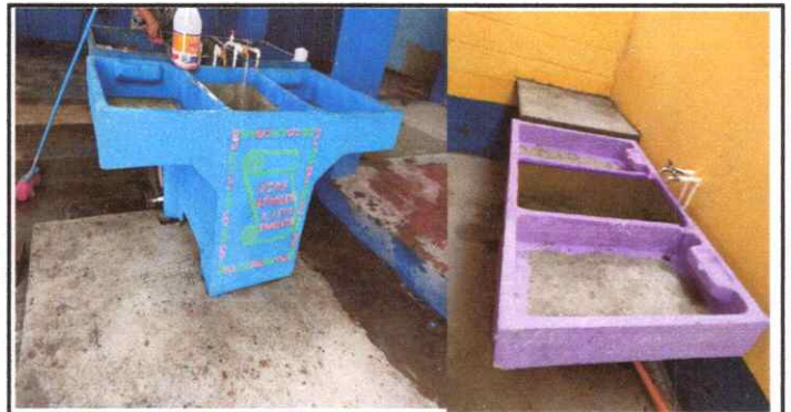
Foto 12: Instalación de pilas con abastecimiento del servicio de agua entubada.
