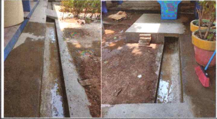
Foto 7: Modificación de Cuneta de Concreto.
