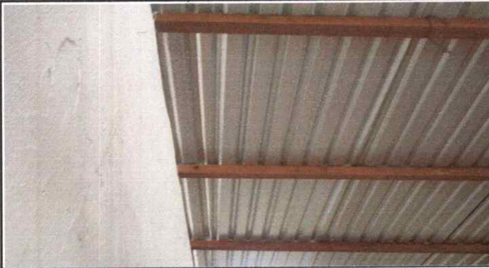
Foto 1: Sustitución de Láminas.
