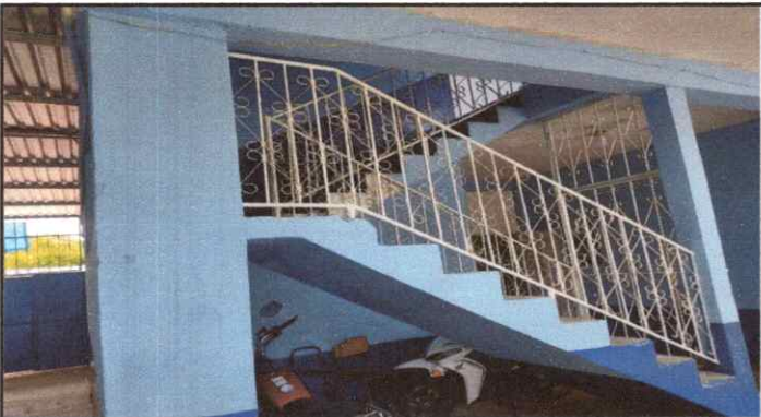
Foto 9: Lijado, Pintura anticorrosiva a Barrantales.
