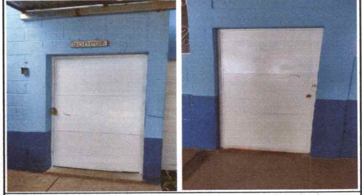
Foto 2: Mantenimiento y pintura anticorrosiva a puertas de todo el establecimiento.
