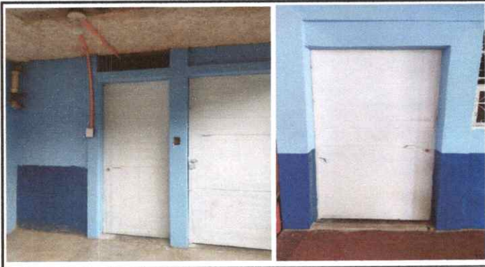
Foto 3: Sustitución de Puertas de Madera.
