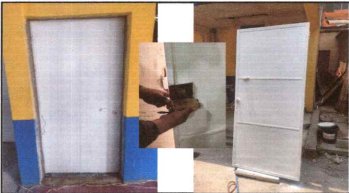
Foto 3: Sustitución de Puertas de Madera.
