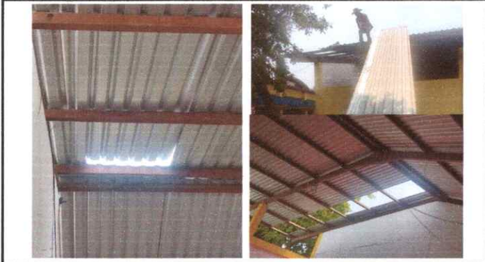
Foto 1: Sustitución de Láminas.
