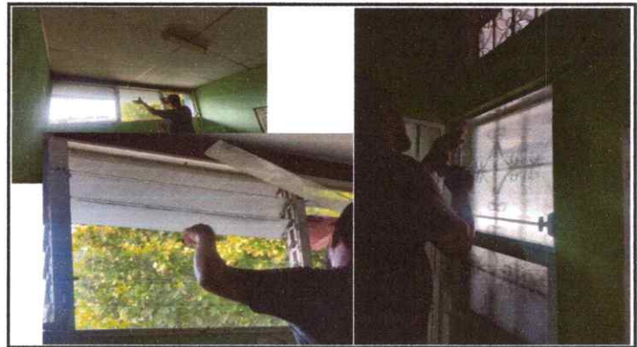
Foto 4: Sustitución de Persianas.
