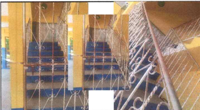
Foto 9: Lijado, Pintura anticorrosiva a Barrandales.
