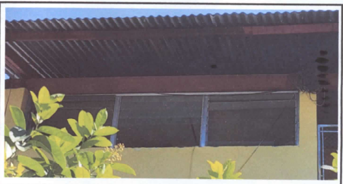
Foto 4: Sustitución de vidrios en persianas en segunda planta.
