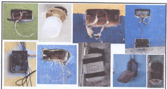
Foto 10: Tomacorrientes, Plafoneras, Interruptores en mal estado en la mayoría de salones y áreas del establecimiento.
