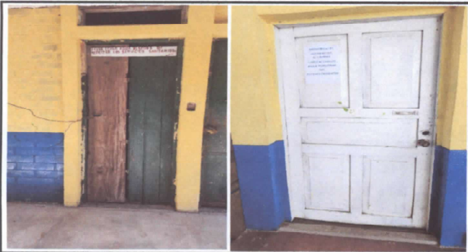
Foto 3: Sustitución de puertas de madera en mal estado.
