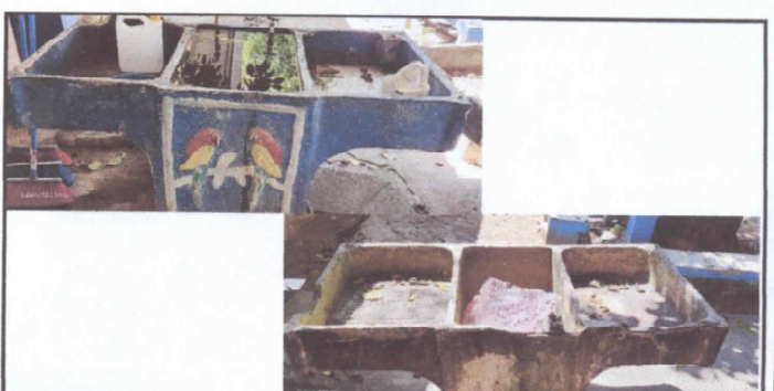
Foto 12: Pilas de cemento en mal estado y con desperfectos.
