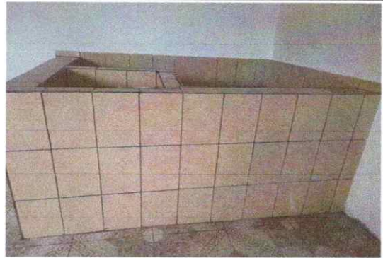
Foto 10: Sustitución de pila de un lavadero
