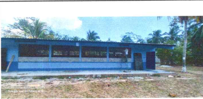
Foto 1: Sustitución de lámina, por lámina troquelada aluzinc calibre 26
