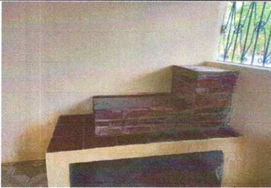
Foto 9: Sustitución de estufa rural
