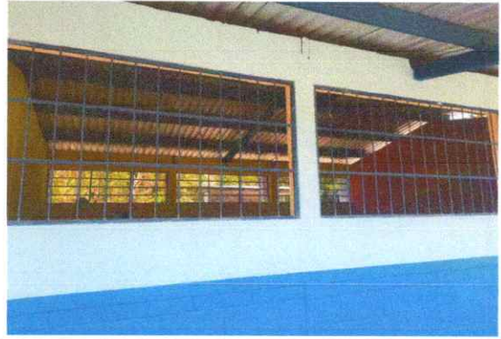
Foto 8: Fabricación e instalación de balcones de hierro en ventana
