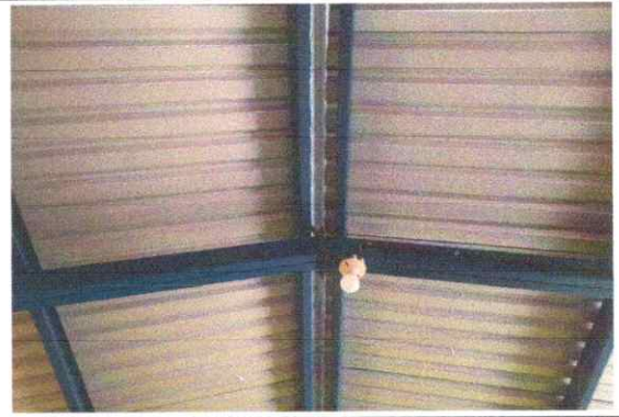
Foto 2: Mantenimiento a estructura de soporte de metal
