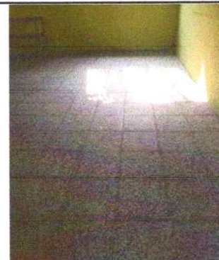
Foto 6: Sustitución de piso de torta de cemento
