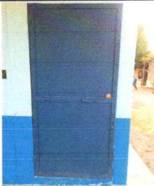
Foto 3: Sustitución de puerta de 90 por 2 metros
