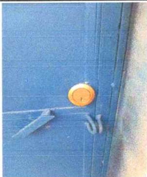
Foto 5: Sustitución de chapas
