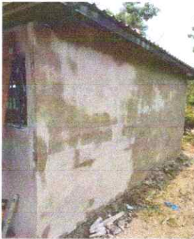
Foto 11: Sellado de grietas y fisura en muros
