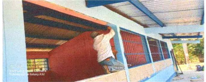
Foto 8: Fabricación e instalación de balcones de hierro en ventana
