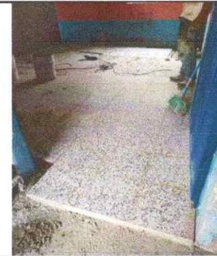
Foto 6: Sustrucción de piso de torta de cemento
