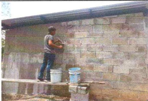
Foto 11: Sellado de grietas y fisura en muros
