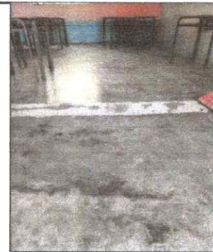
Foto 6: Sustitución de piso de torta de cemento
