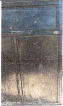
Foto 3: Sustitución de puerta de 90 por 2 metros
