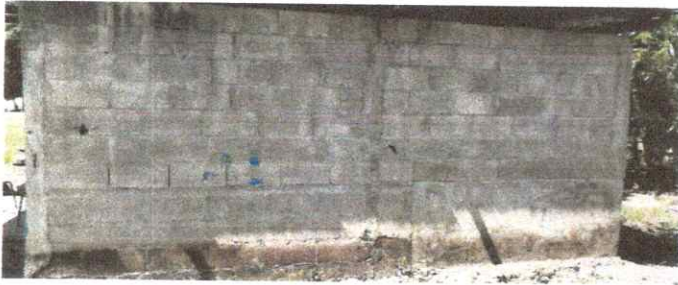
Foto 11: Sellado de grietas y fisura en muros
