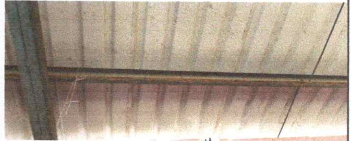
Foto 2: Mantenimiento a estructura de soporte de metal
