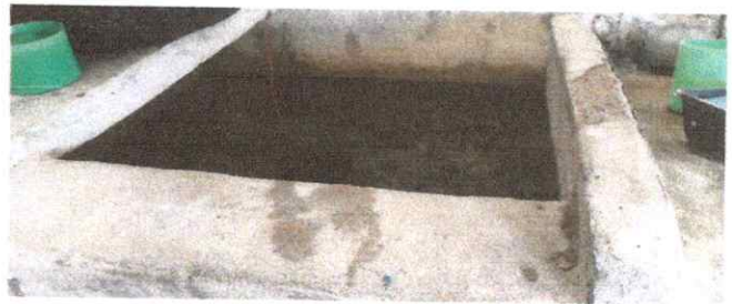
Foto 10: Sustitución de pila de un lavadero
