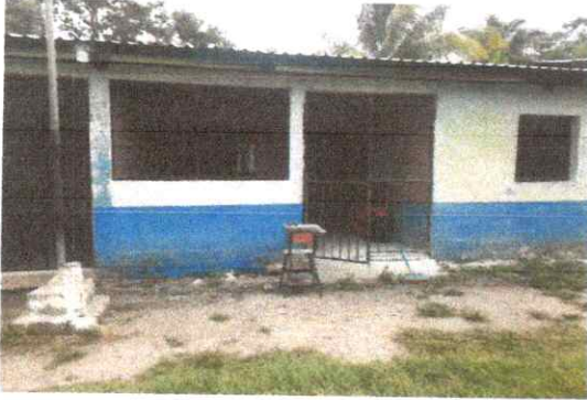
Foto 7: Pinturas en muros exteriores e interiores
