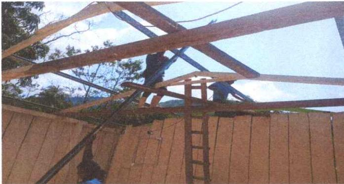
CAMBIO DE LAS BASES DE MADERA PORQUE SE ENCONTRABAN EN MAL ESTADO, POR LA ANTIGÜEDAD.
