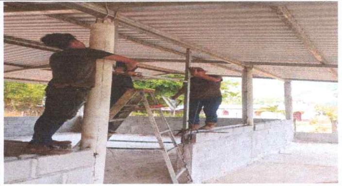
SE DESMONTARON TODAS LAS VENTANAS DE MADERA PARA COLOCAR DE MATERIAL MAS FIRME Y SEGURO.
