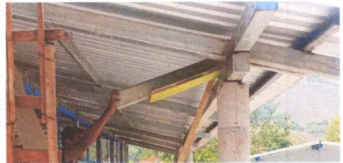
CAMBIO DE ESTRUCTURA DE SOPORTE DE MADERA POR METAL
