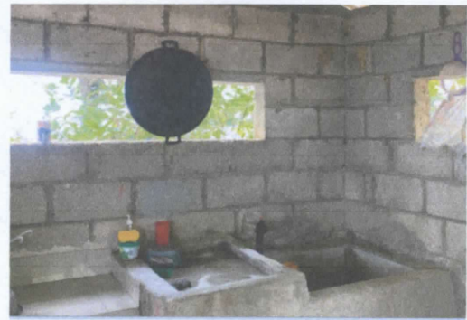
FOTO 10. Repello en muros
