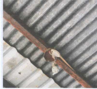
FOTO 8. Sustitución de plafoneras y focos ahorradores
