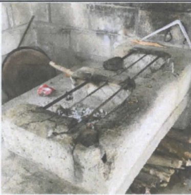
FOTO 9. Reparación de cocina
