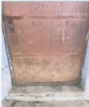
FOTO 3. Sustitución de puerta de metal
