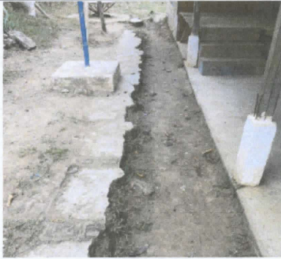
FOTO 7. Reparación de plancha de concreto en patio.
