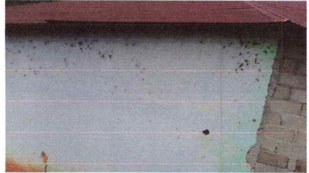
6 PINTURA EN MUROS EXTERIORES Y SUS INTERIORES
