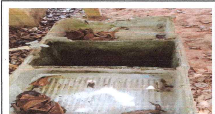
20.10 SUSTITUCION DE PILA DE CEMENTO DE DOS LAVADORES
