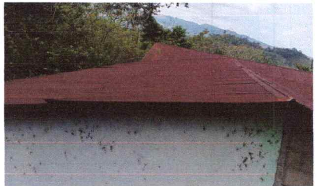
1 CUBIERTA DE LAMINA Y 2 ESTRUCTURA DE TECHO
