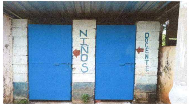
Foto 4. Sustitución de puerta en servicios sanitarios
