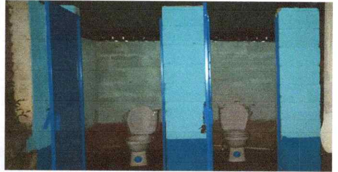
Foto 8. Sustitución de inodoro
