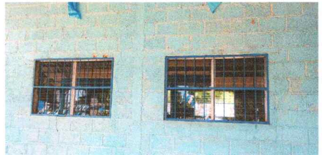
Foto 6. Sustitución de balcones de metal
