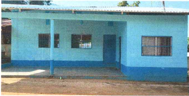
Foto 7. Pintura en muros exteriores e interiores
