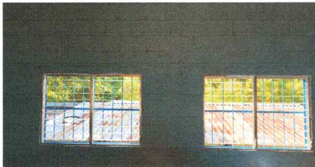
Foto 5. Sustitución de ventana de metal más vidrio
