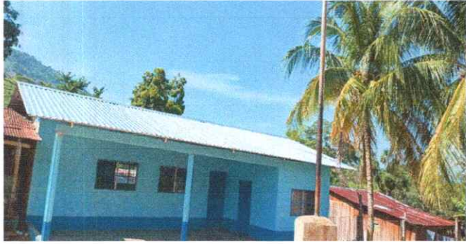
Foto 1. Sustitución de lamina por lamina troquelada
