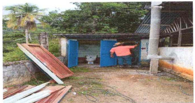
Foto 4. Sustitución de puerta en servicios sanitarios
