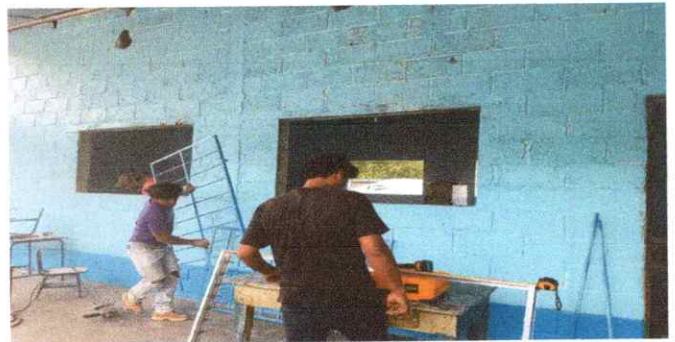
Foto 6. Sustitución de balcones de metal
