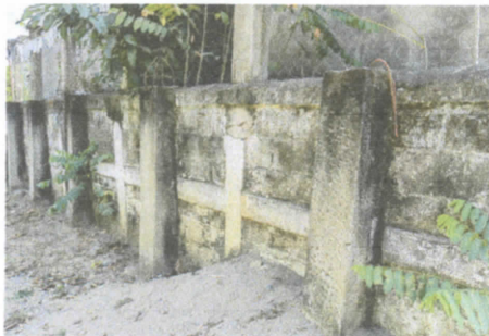
muro de contención
