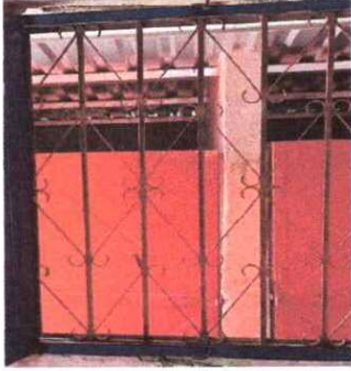
Foto 1: SUSTITUCIÓN DE ESTRUCTURA DE METAL DE VENTANA
