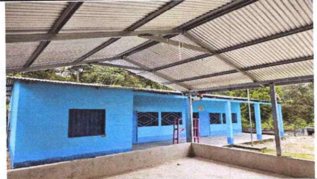
Foto 2: PINTURA EN MUROS EXTERIORES E INTERIORES
