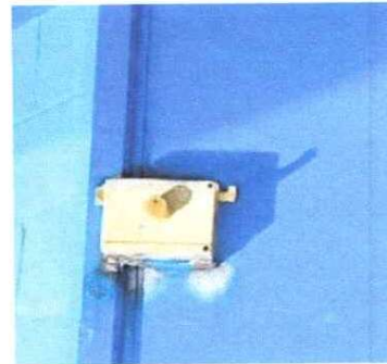
Foto 4: SUSTITUCIÓN DE CHAPA
