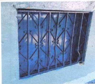
Foto 3: SUSTITUCIÓN DE VENTANAS DE MADERA POR METAL MAS VIDRIO
