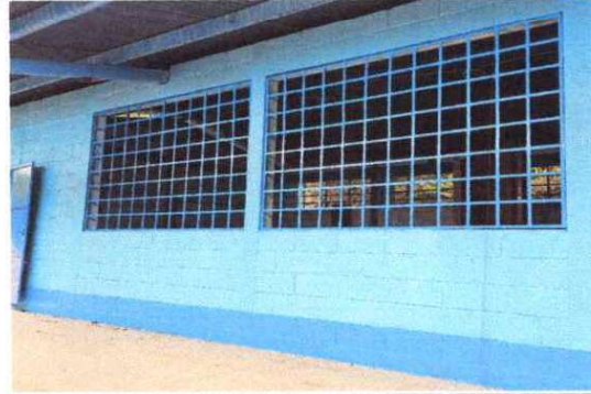
Foto 2: MANTENIMIENTO A BALCONES DE METAL
