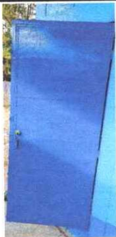
Foto 5: SUSTITUCIÓN DE PUERTA
