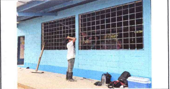
Foto 2: MANTENIMIENTO A BALCONES DE METAL
