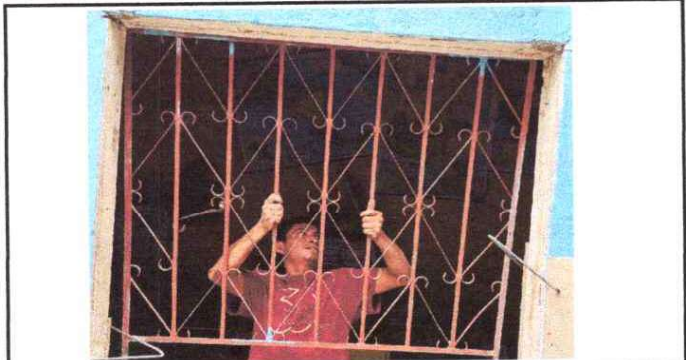
Foto1: SUSTITUCIÓN DE ESTRUCTURA DE METAL DE VENTANA
