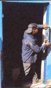
Foto 5: SUSTITUCIÓN DE PUERTA
