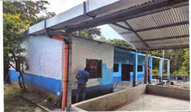
Foto 2: PINTURA EN MUROS EXTERIORES E INTERIORES
