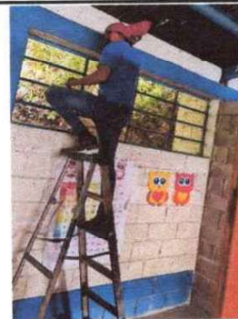
Foto 6: MANTENIMIENTO A ESTRUCTURA DE METAL DE VENTANA
