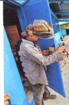
Foto 4: SUSTITUCIÓN DE CHAPA
