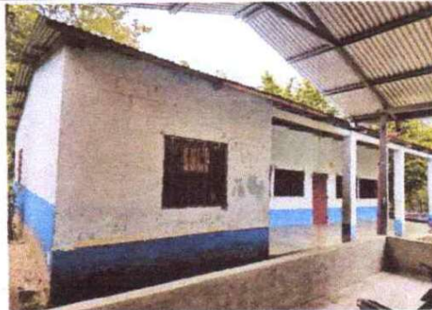
Foto 2: PINTURA EN MUROS EXTERIORES E INTERIORES
