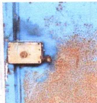
Foto 4: SUSTITUCION DE CHAPA
