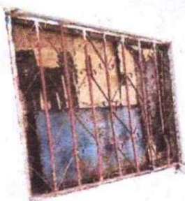
Foto 3: SUSTITUCION DE VENTANAS DE MADERA POR METAL MAS VIDRIO
