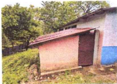
Foto1: REMOZAMIENTO ESTRUCTURAL EN AREA DE BAÑOS, SUSTITUCION DE LAMINA TROQUELADA ALUZINC CALIBRE 26
