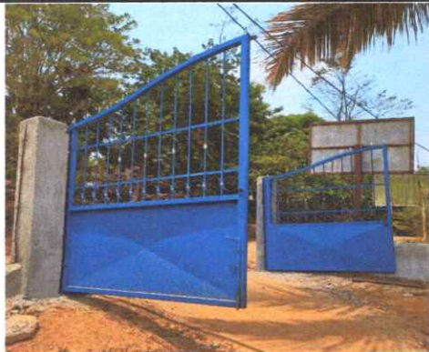
Sustitución de portón de metal
