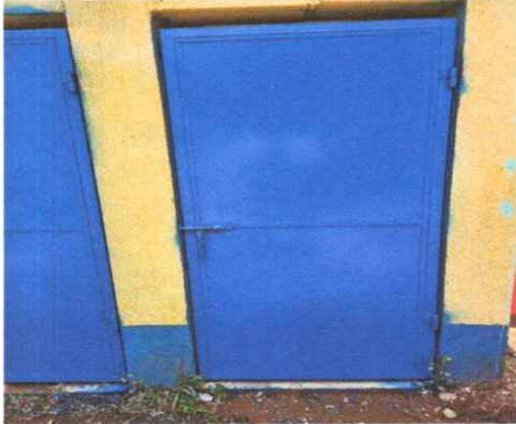
Mantenimiento a estructura de puerta
