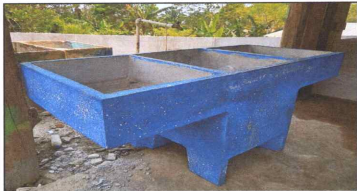
Sustitución de pila de cemento
