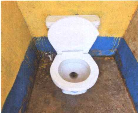
Sustitución de accesorios de inodoro
