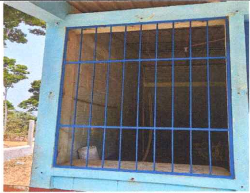
Sustitución de balcón de metal
