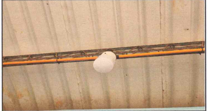
Reparación de sistema eléctrico
