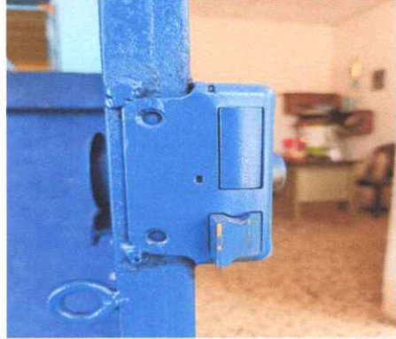
Sustitución de chapa
