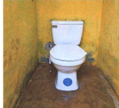
Sustitución de inodoro
