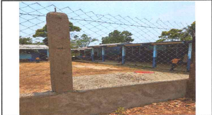
Reparación de muro perimetral
