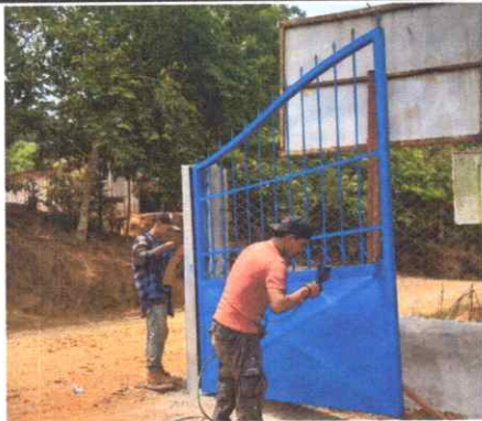
Sustitución de portón de metal
