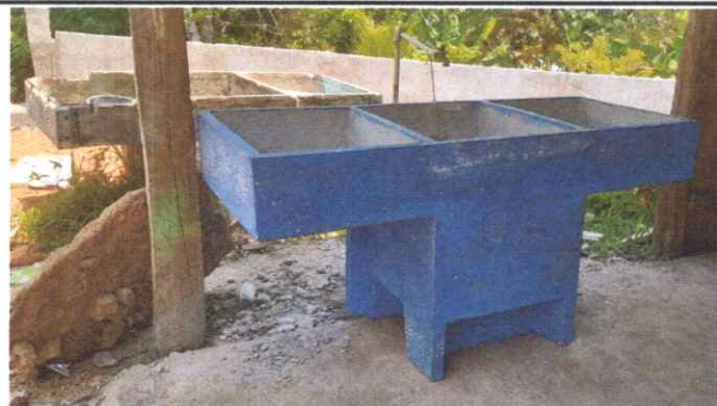
Sustitución de pila de cemento
