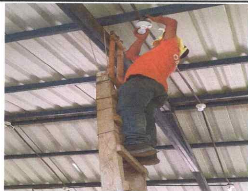
Reparación de sistema eléctrico
