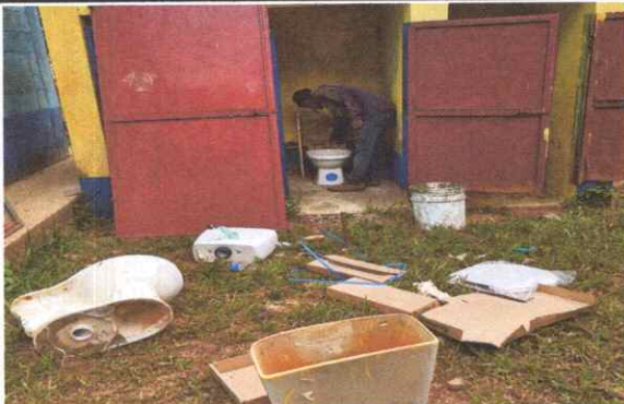
Sustitución de accesorios de inodoro
