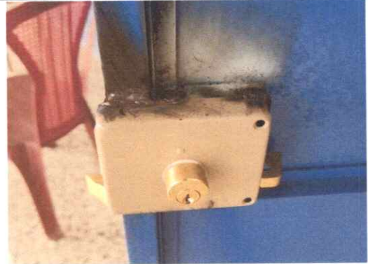
Sustitución de chapa
