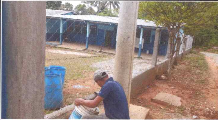
Reparación de muro perimetral
