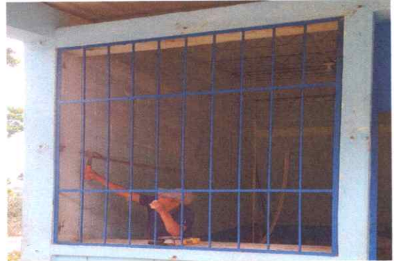
Sustitución de balcón de metal
