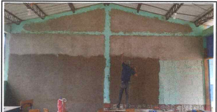
Repello en muro
